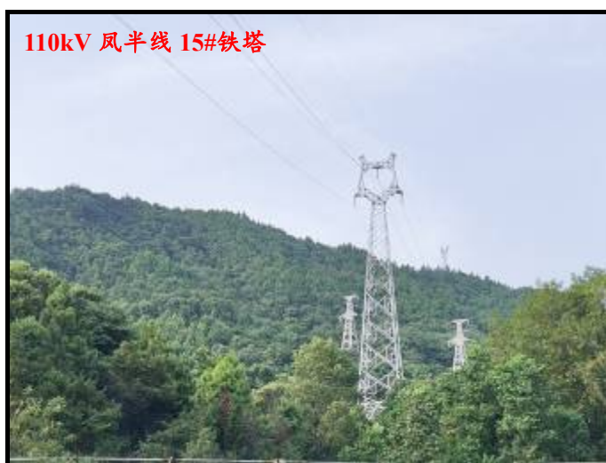
图 2-4 110kV 风半线 \pi 接点附近现状情况照片
