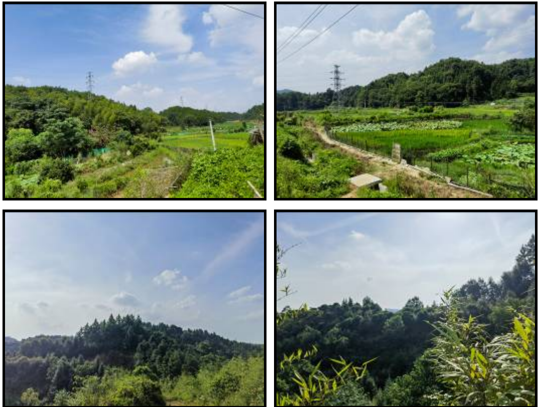
图 3-3 本项目输电线路沿线生态环境现状照片
